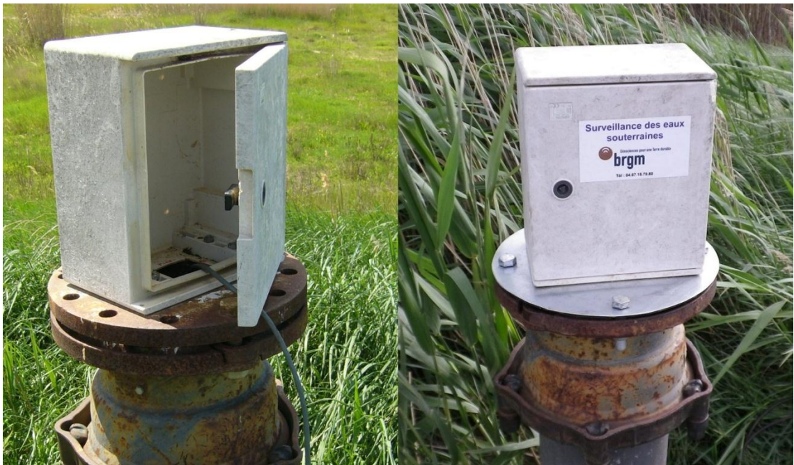
Illustration 5 : Remplacement de la plaque de protection de l'ouvrage sur le site de Corneilla (gauche : vue de l'ouvrage avec la plaque ancienne corrodée ; droite : vue de la nouvelle plaque en place).
