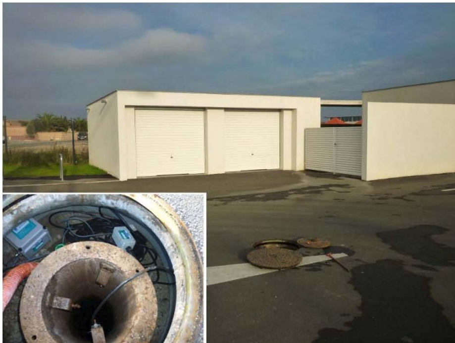
Prise de vue sur l'ouvrage
