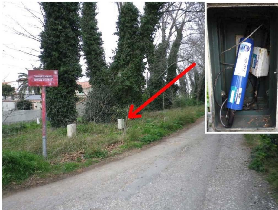
Prise de vue sur l'ouvrage
