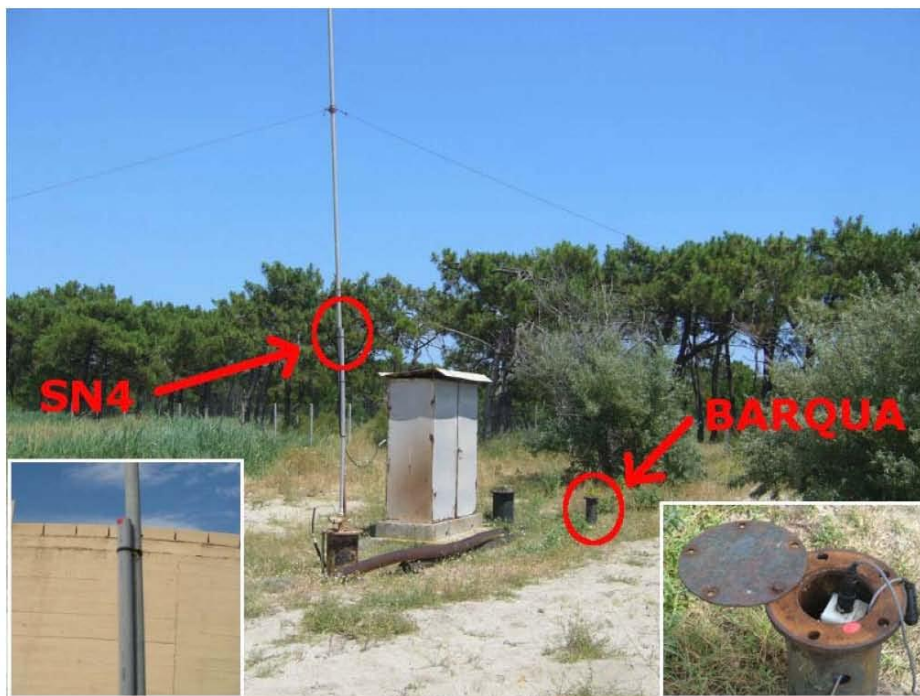
Prise de vue sur l'ouvrage
