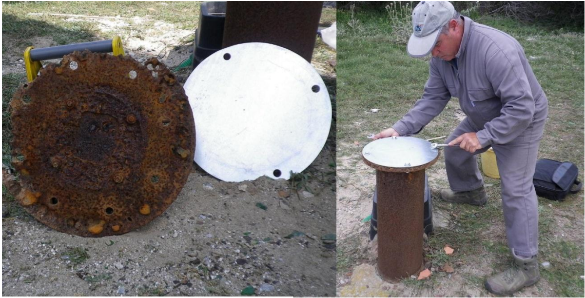
Illustration 4 : Remplacement de la plaque de protection de l'ouvrage sur le site de Canet plage (gauche : vue de la plaque ancienne corrodée et de la nouvelle ; droite : vue de la nouvelle plaque en place).
