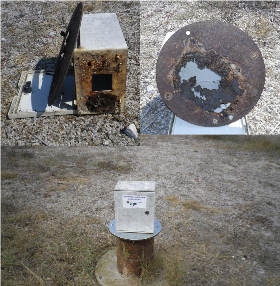
Illustration 3 : Remplacement de la plaque et de l'armoire sur le site du Barcarés plage (haut : anciennes armoire et plaque corrodées ; bas : nouvelles plaques et armoires installées).
