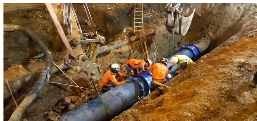
Réparation d'une fuite d'eau Avenue Dalbiez à Perpignan (octobre 2021)
