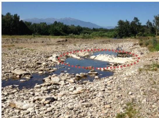
Photo de droite prise durant les travaux de dérivation de la Têt en aval de la fosse (18/07/2014)
