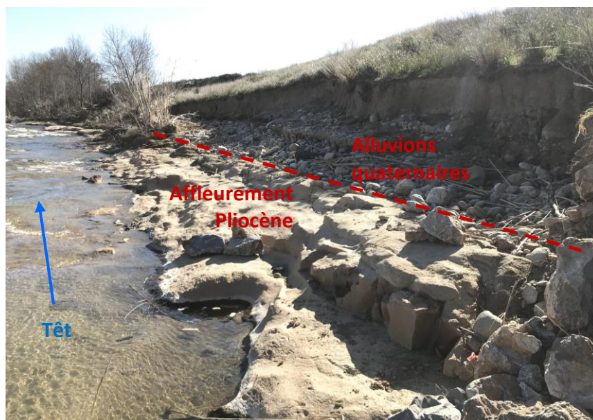
Figure 2 - Alluvions quaternaires déconnectées de la Têt par l'érosion
