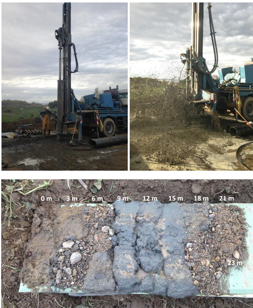
Illustration 15 - Photographies du chantier du site de Sainte Marie (novembre 2016)
