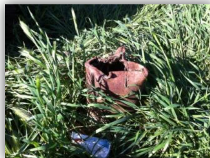
Figure 47 : forage abandonné
