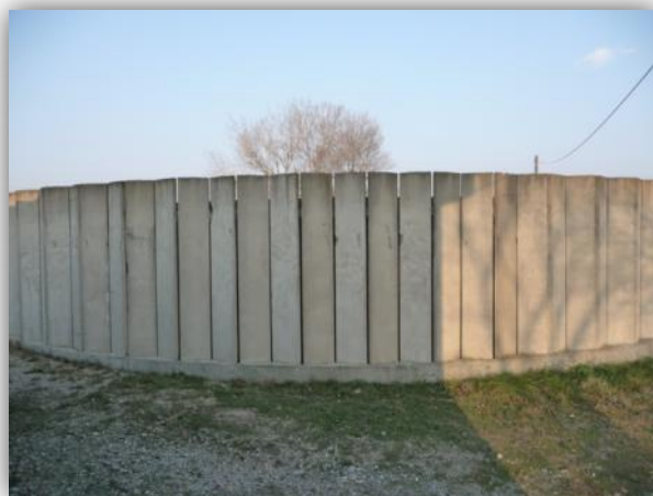
Figure 32 : bâche de stockage d'eau potable
